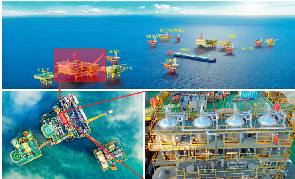
WHP: Wellhead Platform 井口平台, 后续字母为标号 CEP: Central Equipment Platform 中心平台, 后续字母为标号 FPSO: Floating Production Storage and Offloading 浮式生产储油船 EPP: Electric Power Platform 岸电平台
